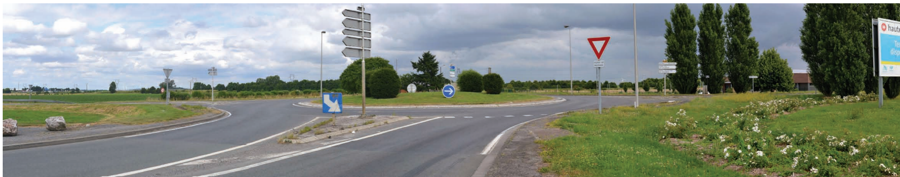
Etat initial du photomontage dans un angle de 120°, avec les parcs éoliens construits et accordés
